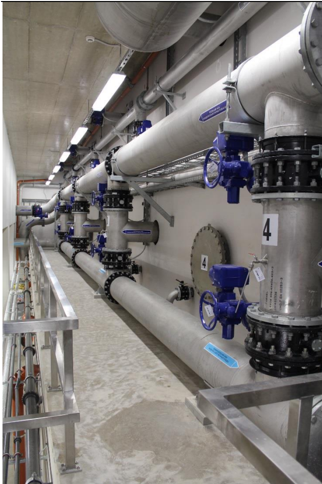
Foto 5.4 Kahekihilised filtrid ja juhtarmatuur
