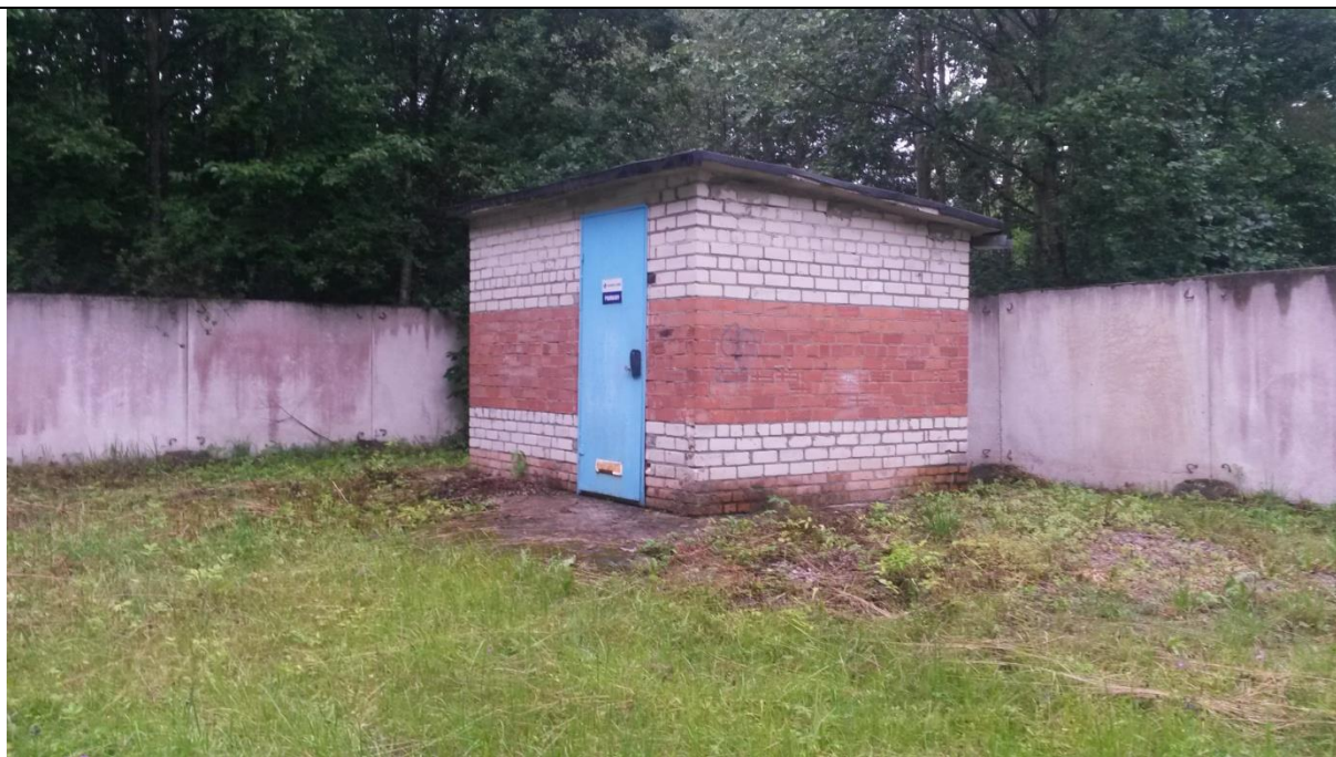
Foto 5.8 Siivertsi puurkaevpumpla välisvaade
