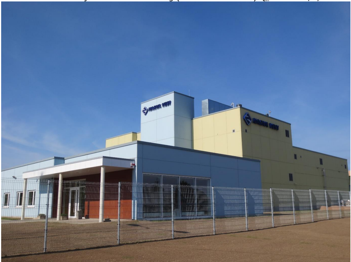
Foto 5.2 Uue veetöötlusjaama välisvaade (2015 suvi)
