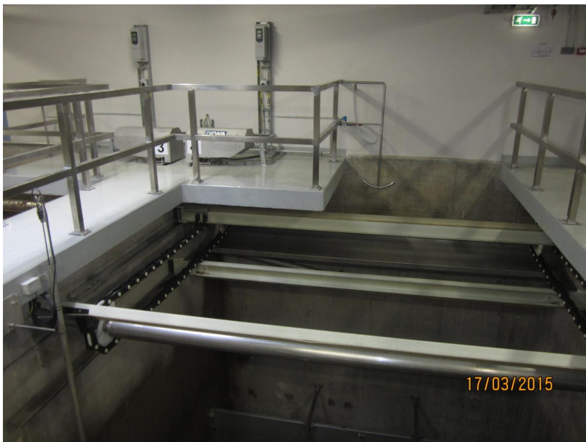
Foto 5.3 Narva linna veetöötlusjaama SPIDFLOW® flotatsioonibasseinid
