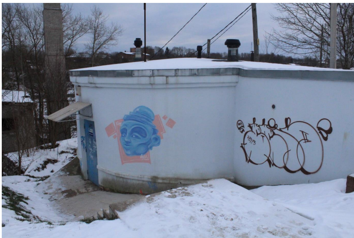
Foto 6.2 Kanalisatsiooni pumpla nr 5
