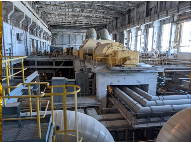
Joonis 3.6. BEJ 11. ploki Turbiin
