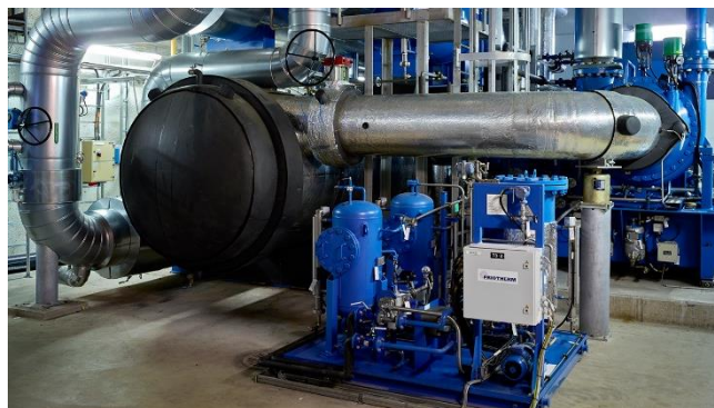
Рисунок 5.14. Тепловой насос для станции централизованного теплоснабжения и охлаждения Katri Vala 120
